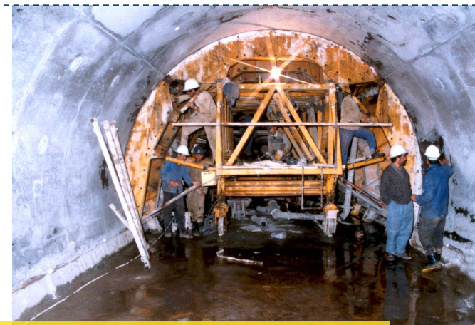
عملیات لاینینگ داخل تونل - عملیات ریپ رپ
